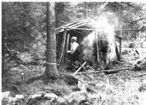
Просушка и ремонт таёжной избушки в Ключках
