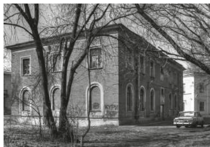
Комплекс построек малолетнего отделения Николаевского сиротского института («Куракина дача»). Хозяйственная постройка. Ул. Бабушкина, 58, к. 2.
