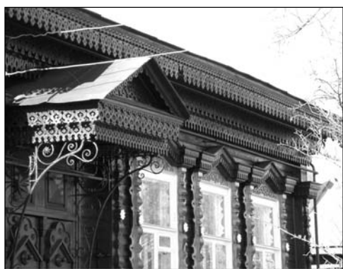
Деревянные резные наличники. Козырьки над парадными входами в жилые здания
