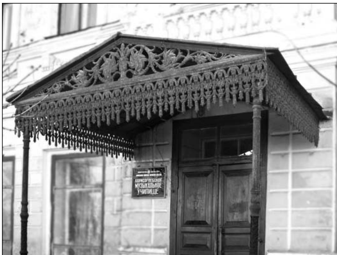
Ул. Свободы, 213. Над входом навес на чугунных фигурных столбах
